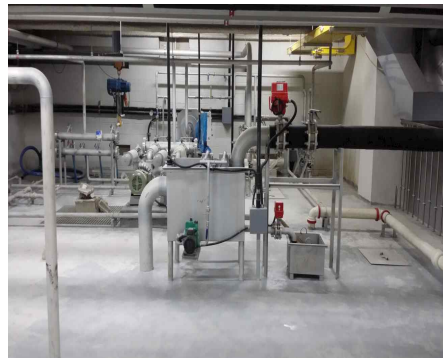
[그림] 우수(빗물) 처리 시스템
